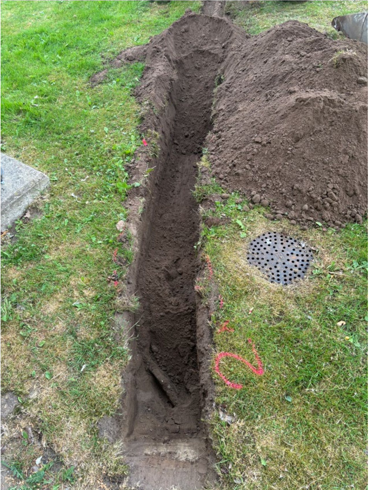
Fig. 3. Närbild på schakt 1 (OS200). Mot NÖ. Foto nr: 2026-41-1. Foto: Lina Dahlqvist.
